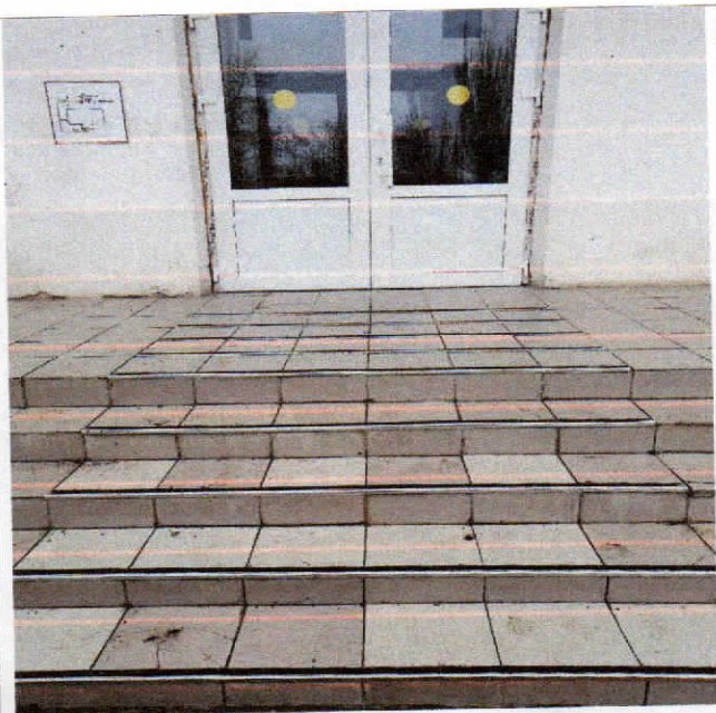
Фото №2 – Вход в здание
