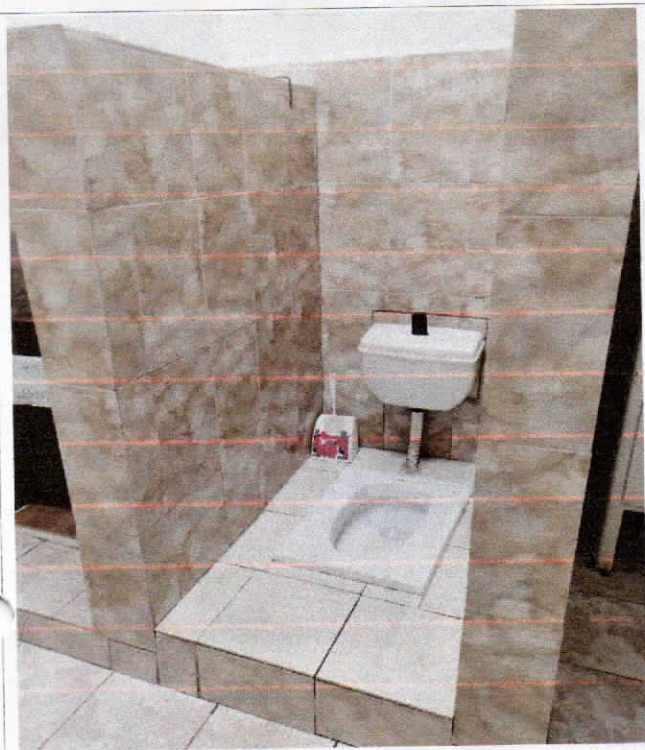
Фото №6 – Санитарно-гигиенические помещения
