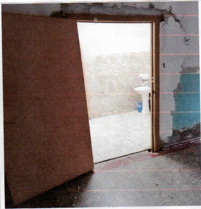
Фото №6 – Санитарно-гигиенические помещения
